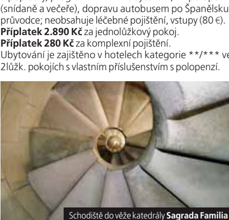
Schodiště do věže katedrály Sagrada Família
